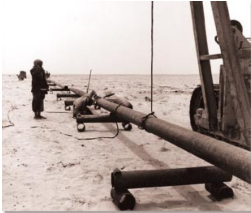
عملية تمديد أنابيب النفط
